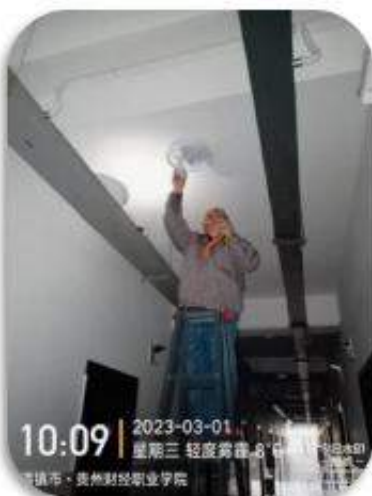
宿舍过道照明灯、安全出口灯维修
