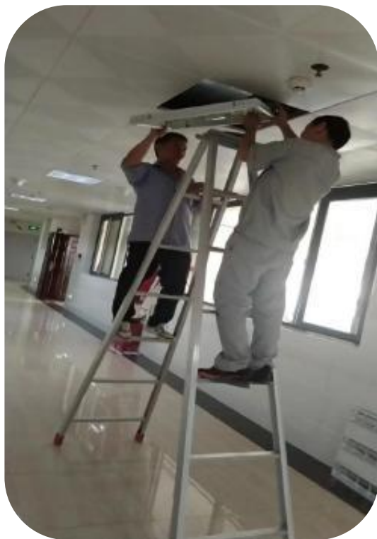
教学楼过道灯具更换
