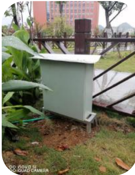
荷花池雾化器安装
