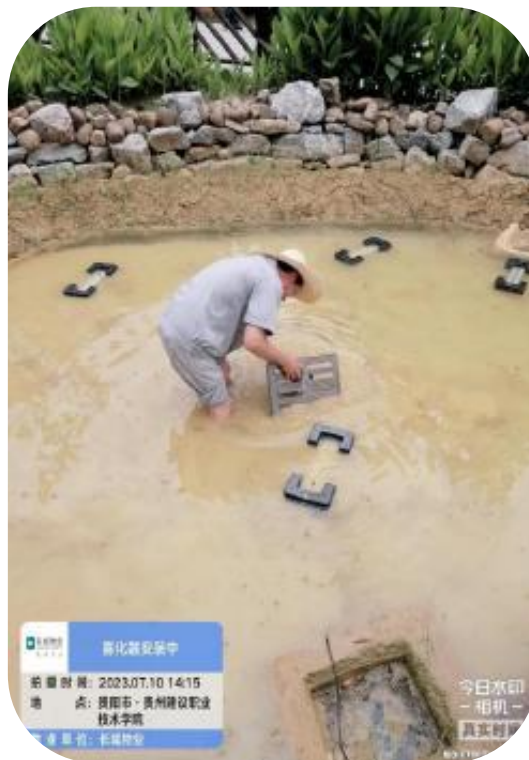
荷花池雾化器安装调试
