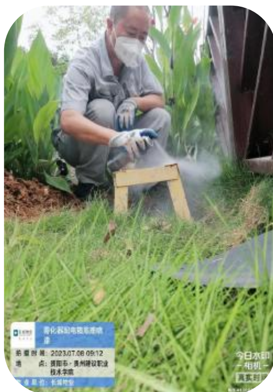
荷花池配电箱基座制作上漆
