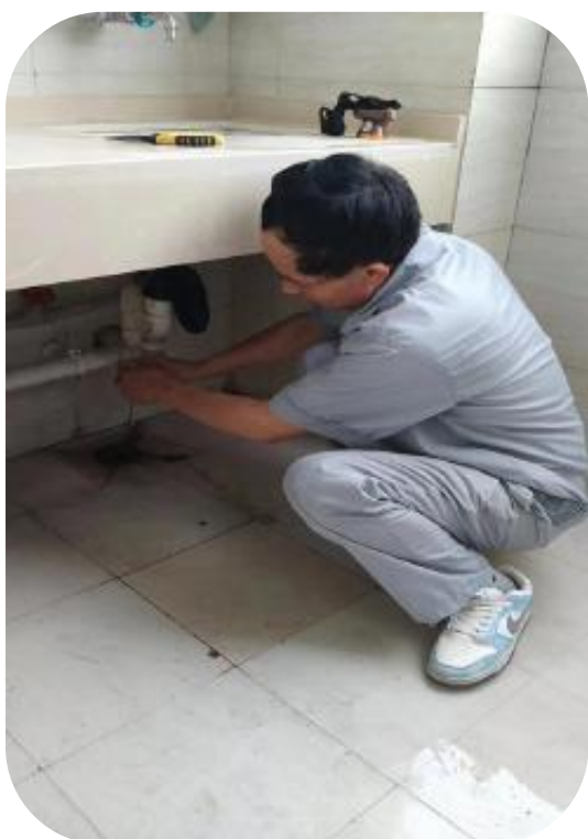
宿舍排水管修复
