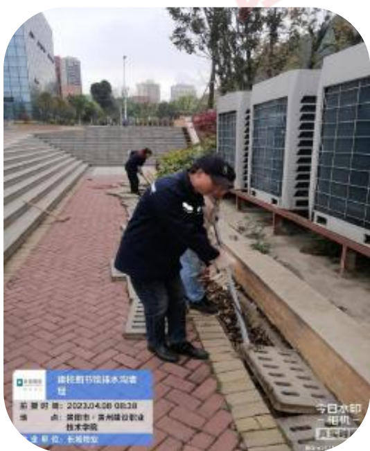
图书馆排水沟疏通图片
