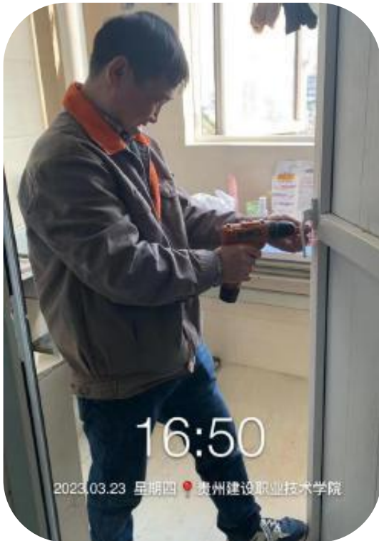
宿舍门窗修理
