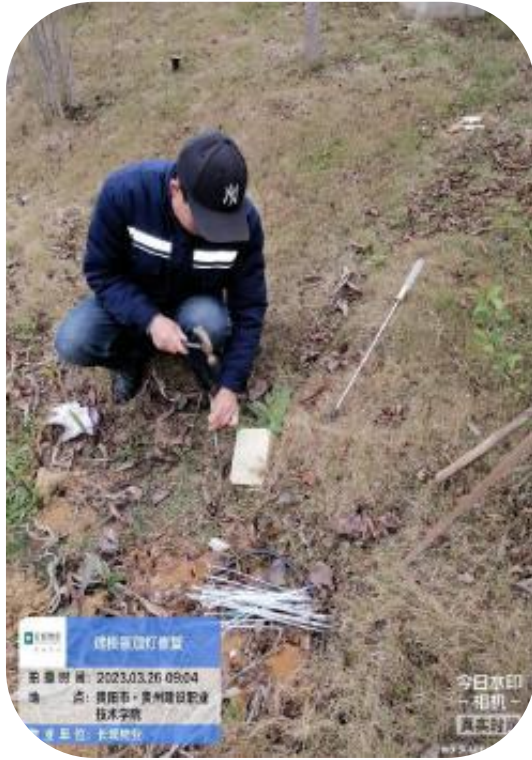
鲁班广场景观灯修理
