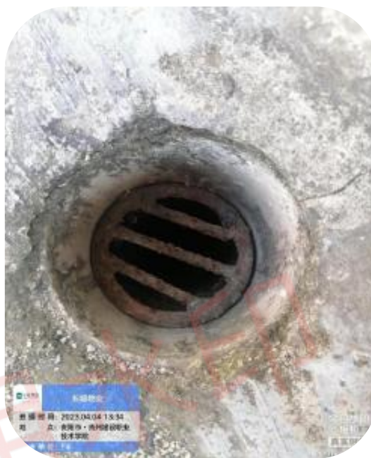
楼顶排水管疏通图片
