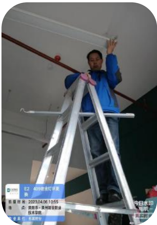
E2 照明灯具损坏更换
