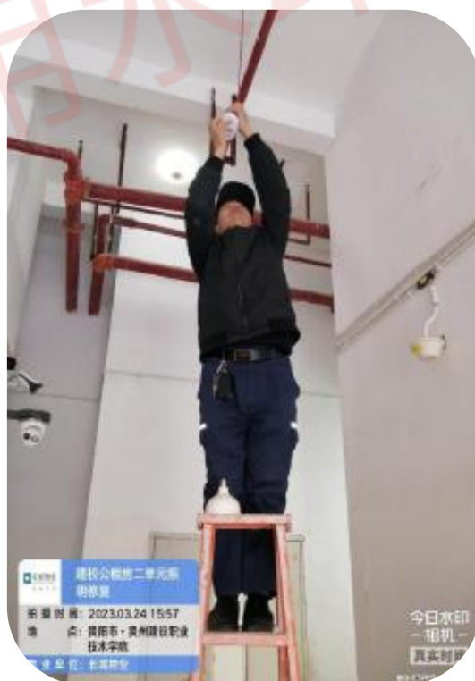
公租房照明修复
