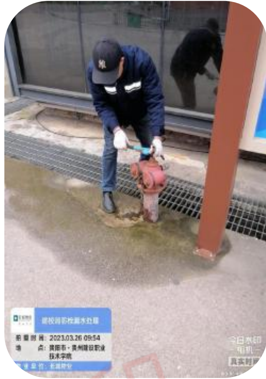
F4 消防栓漏水处理
