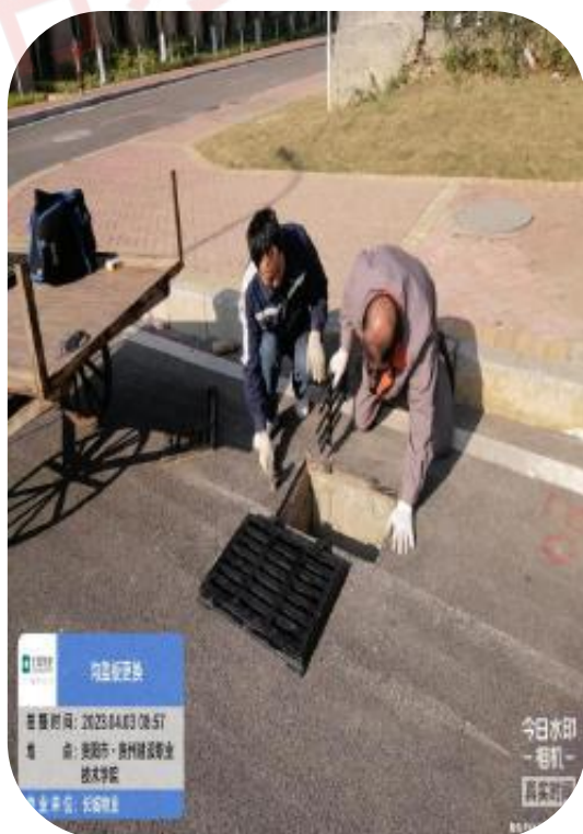
图书馆前沟盖板更换图片
