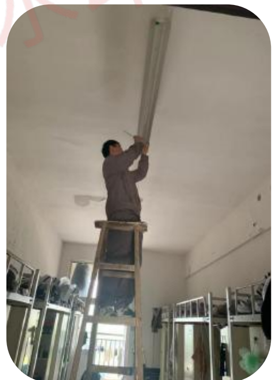
宿舍更换照明灯具
