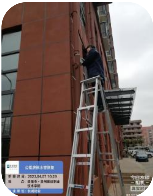
公租房排水管脱落修复图片
