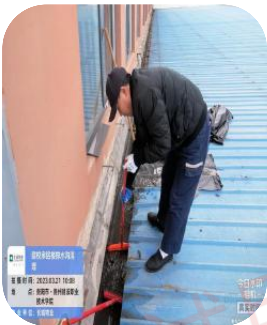
楼顶排水管疏通后图片
