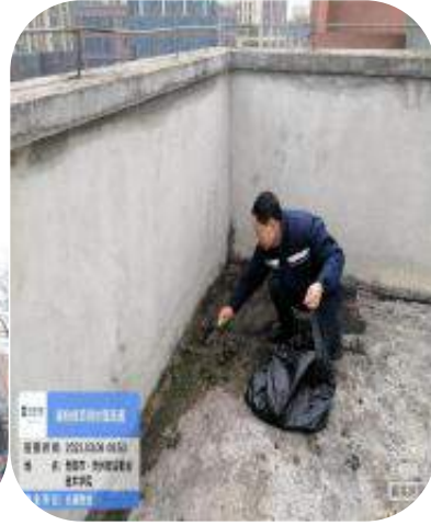
楼顶排水口疏通
