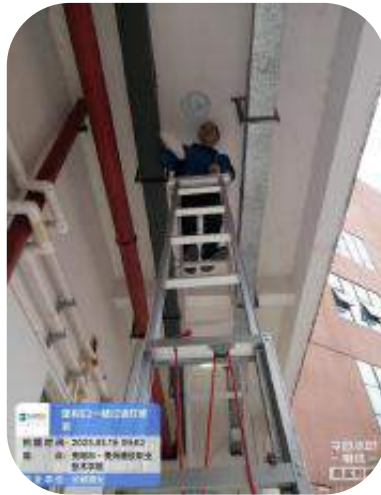
E2 过道灯更换
