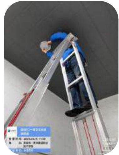
E2 一楼卫生间照明修复
