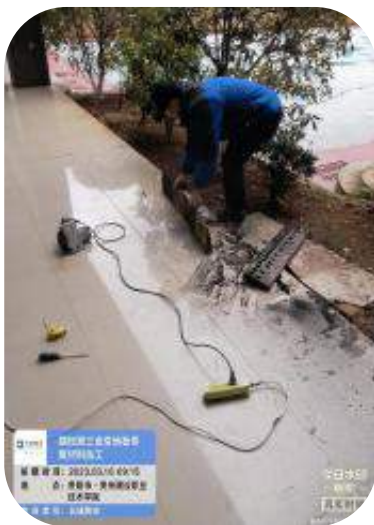
三食堂地板修复材料加工 图书馆排水沟水泥修复加固
