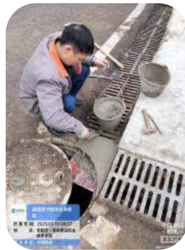
三食堂地板修复材料加工 图书馆排水沟水泥修复加固
