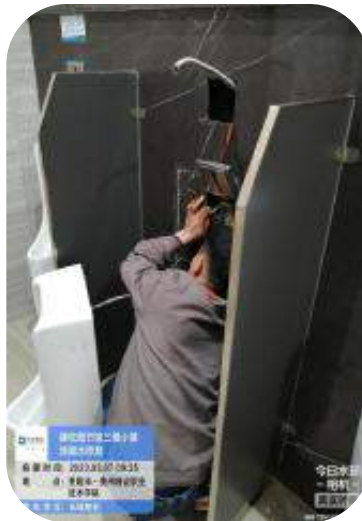
图书馆便池漏水维修
