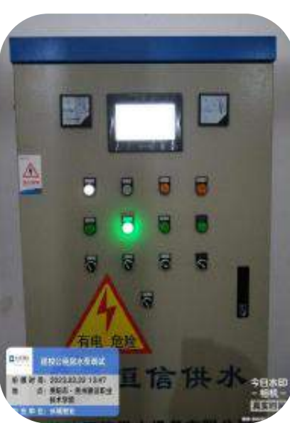
公租房水泵调试
