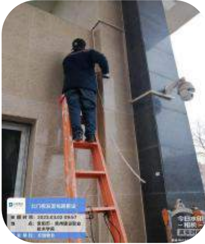
北门收发室线路铺设
