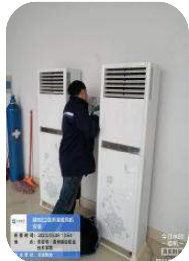
医务室暖风机安装
