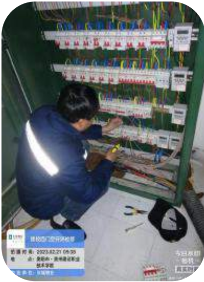
西门空开控制柜设备检修
