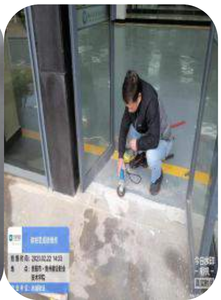
进口地面打磨处理
