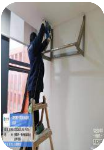
图书馆健身器材安装
