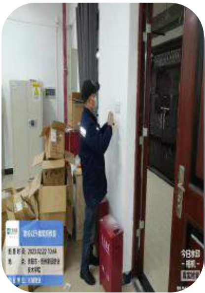
以升楼照明修复
